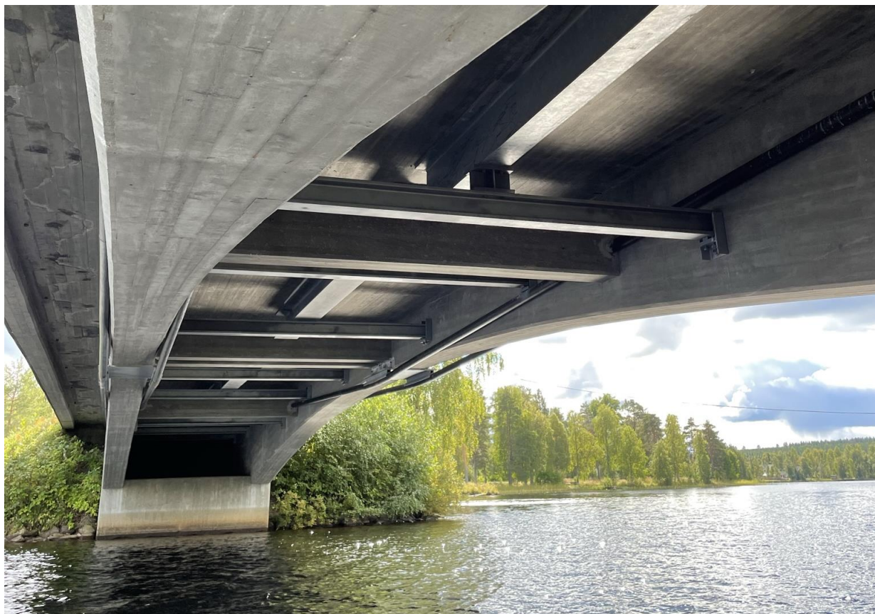
Vid passage under bron syns förstärkningarna som utfördes 1992 tydligt. Ursprungligen hade bron inga synliga balkar utöver de två välvda betongbalkarna. Till vänster syns även att kantbalkarna delvis gjutits om.
