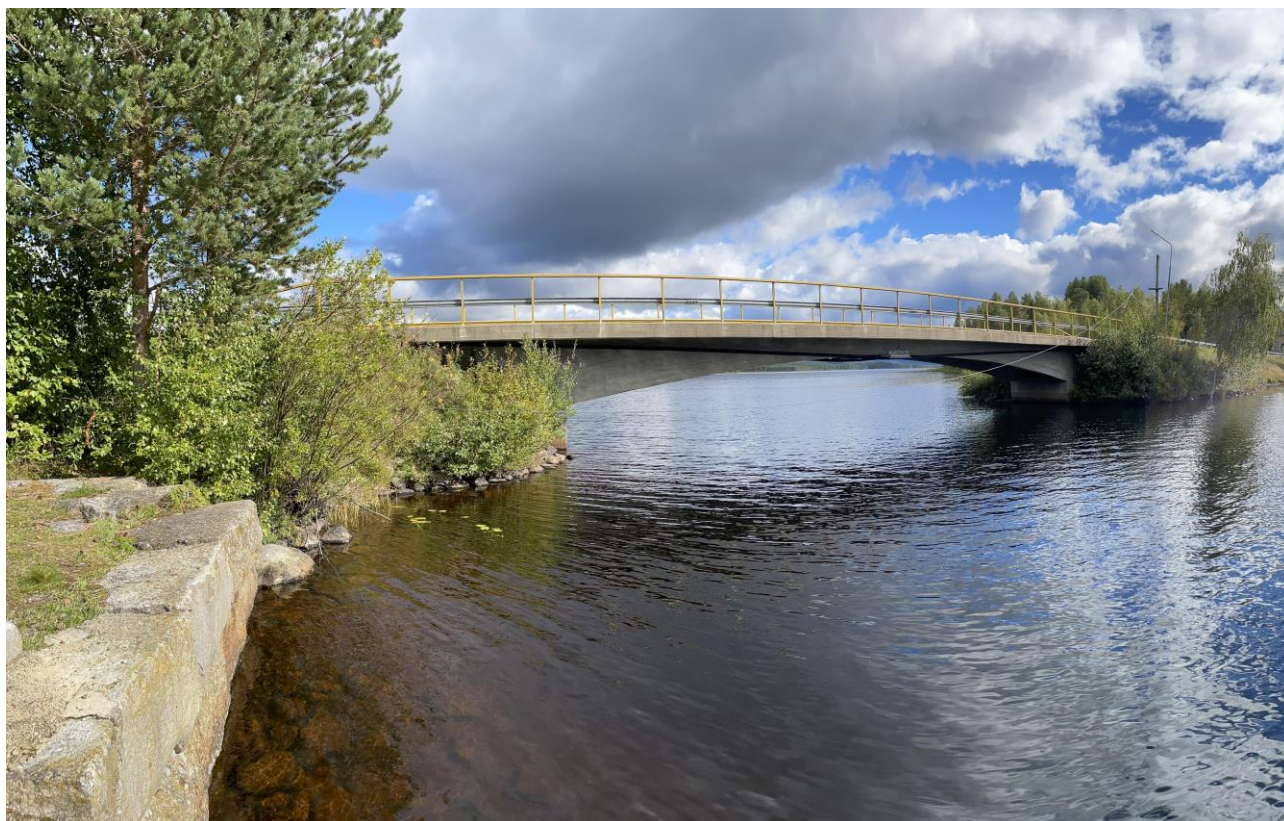
Den nuvarande bron fotograferad med den äldre bronns norra fundament i förgrunden till vänster. Den äldre bronns södra fundament skymtar i buskaget precis bredvid betongbron till höger i bild.
