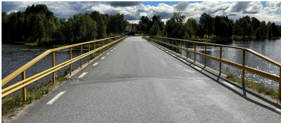
Figur 5. Befintlig bro över Viskasundet. Foto: Norconsult AB.
