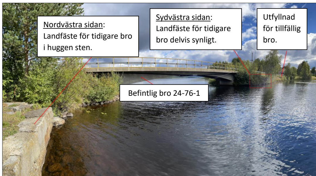
Figur 10. Översiktsbild av västra sidan av befintlig bro där tillfällig bro föreslås anläggas. Foto: Norconsult
